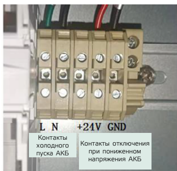
Рис. 3-38: Сухие контакты данной серии (160 – 300 кВА)
