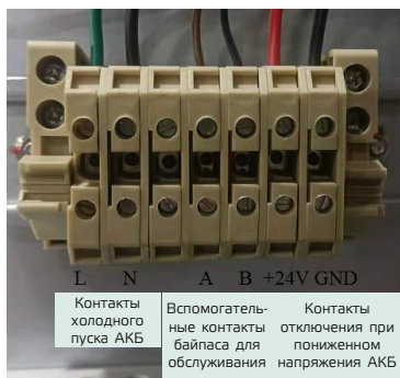
Рис. 3-39: Сухие контакты данной серии (400 – 500 кВА)
