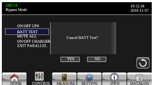
Отмена теста АКБ
